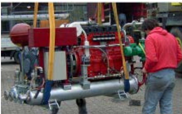
Abbildung 16: BHKW-Modul während der Einbringung mit dem Autokran (noch ohne Schallschutzhaube)
