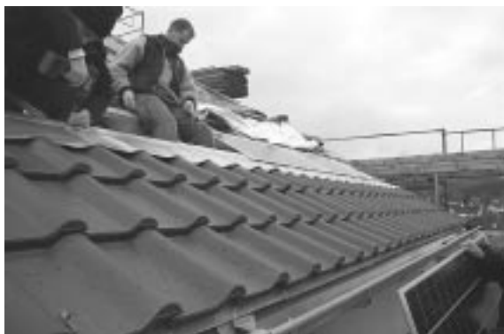
Abbildung 8: Montage der ersten Solarmodule auf dem Dach des Aggertal-Gymnasiums im Herbst 2001
